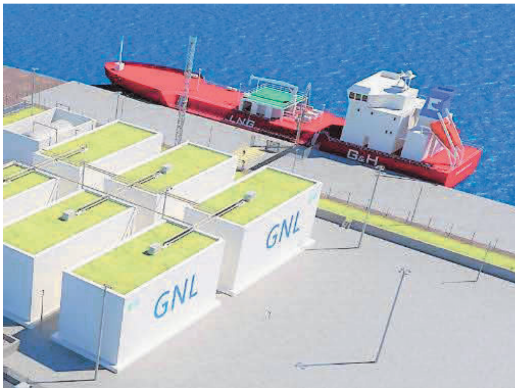
Figura 3: Oristano - Rigassificatore in terra ferma e nave gasiera attraccata che scarica GNL
