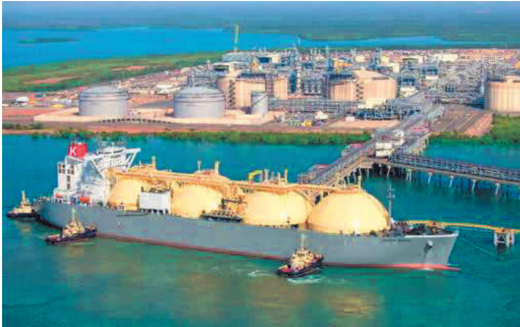
Figura 2: Deposito e rigassificazione di GNL in terraferma a Barcellona con nave gasiera in fase di carico/scarico
